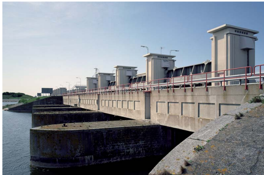
De sluiscomplexen in de Afsluitdijk hebben ook een functie als stormvloedkering
