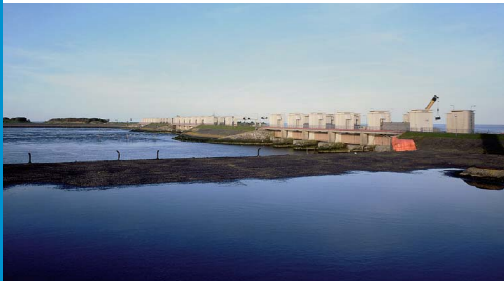
De Stevinsluizen bij Den Oever
