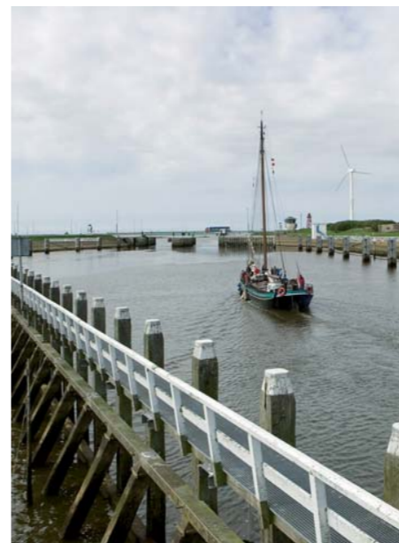
De schutsluizen van Den Oever en Kornwerderzand zorgen voor het doorlaten van schepen van en naar de Waddenzee
