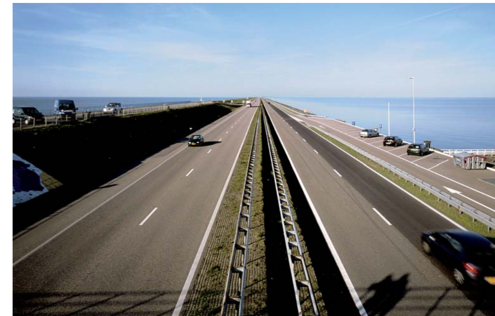
In 1976 is de voor rails gereserveerde ruimte benut voor het verbreden van de rijweg
