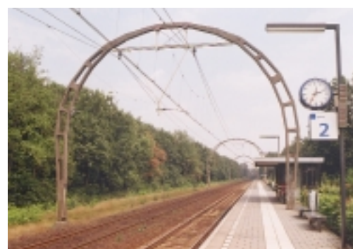
Station Hollandsche Rading ligt aan de spoorlijn Utrecht-Hilversum. De bovenleidingportalen uit 1938 zijn een gaaf bewaard en zeldzaam voorbeeld van geprefabriceerde, betonnen spoorwegportalen in Nederland, en bovendien zeer beeldbepalend
