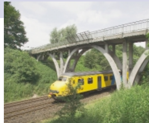
Viaduct Klimmen-Voerendaal uit 1914 is onderdeel van de spoorlijn Heerlen-Schin op Geul. De gebruikte techniek, met drie overspanningen met zogenaamde staande korfbogen, was vrijwel zeker nooit eerder in Nederland toegepast
