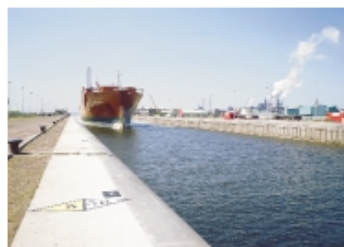
Het zeesluizencomplex in IJmuiden is sinds de opening in 1876 al drie keer fors uitgebreid. De discussie over de noodzaak van een vierde uitbreiding loopt nog
